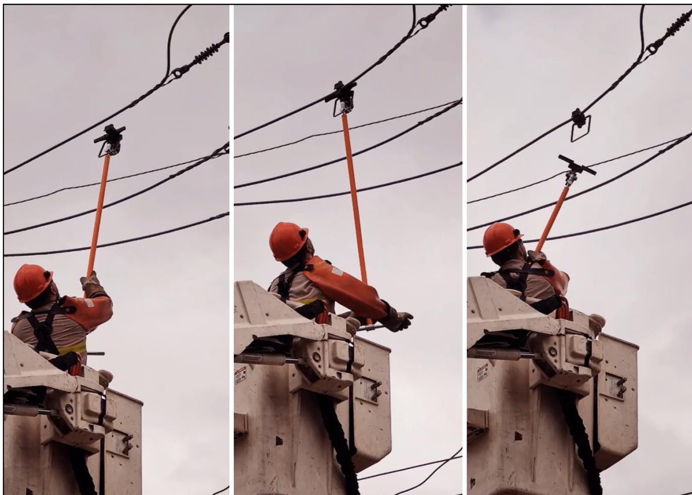
Figura 8 – Detalhe da aplicação do conector na rede pelo método a distância
